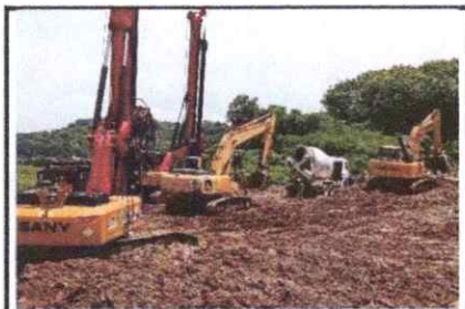
Pekerjaan galian urugan pemadatan area zona 1 dan zona 2
