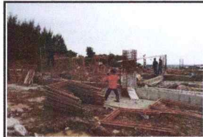
Kegiatan proses pekerjaan pengecoran pile cap zona 1
