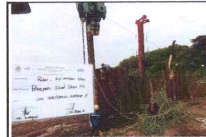
Pekerjaan pemasangan struktur steel sheet pile zona 1
