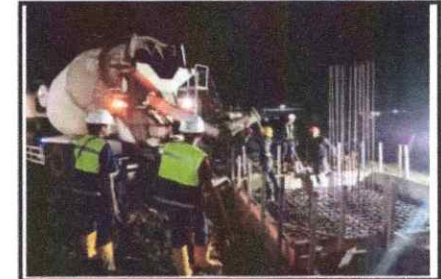
Kegiatan proses pekerjaan pengecoran pile cap zona 1
