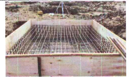
Pekerjaan Bekisting Pilecap
