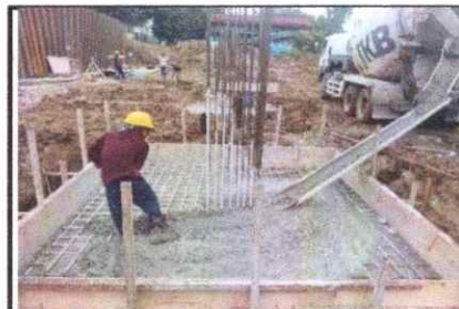
Pekerjaan Pengecoran Pilecap P4 zona 2
