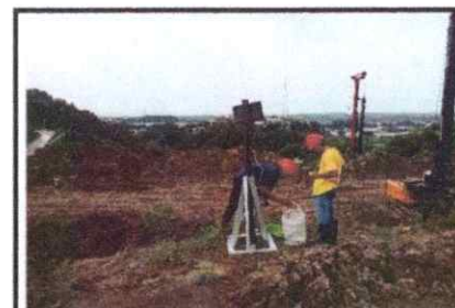
Pekerjaan surveyor untuk elevasi dan titik pile cap, bored pile dan secan pile
