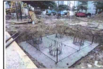
Pekerjaan marking dimensi pile cap dan instal tulangan pile cap
