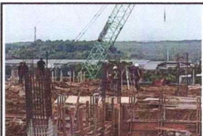
Pekerjaan pembukaan bekisting tea beam zona 1
