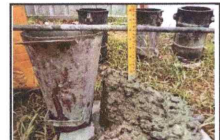
Pekerjaan test slump beton sebelum pengecoran pile cap/tea belam
