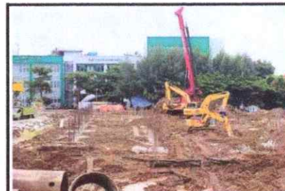
Kondisi setelah di lakukan pengecoran pile cap dan perataan area pile cap
