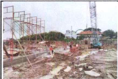
Kondisi setelah di lakukan pengecoan pile cap dan perataan area pile cap
