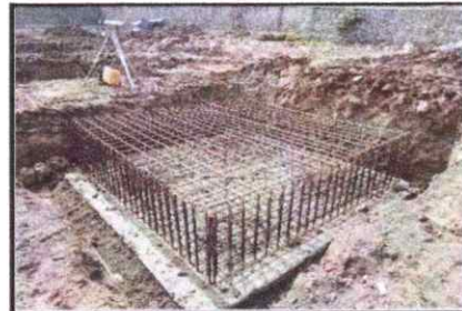
Pekerjaan instal tulangan pile cap dan persiapan pasang bekisting dan checklist
