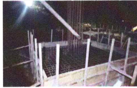
Pekerjaan Pembesian Pilecap
