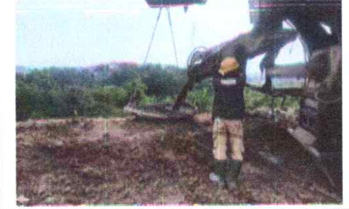
Pekerjaan Pengecoran Secant Pile
