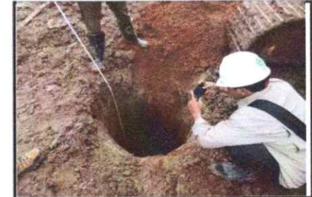
Pengukuran kedalaman preboring dan borepile
