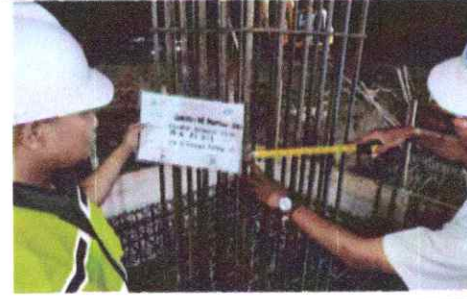
Pekerjaan Pembesian Stek Kolom
