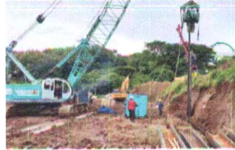
Pekerjaan SSP Zona 2
