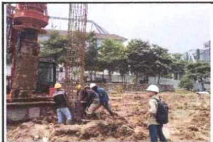
Erection tulangan bered pile pada titik lubang dan persiapan pengecoran
