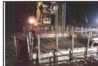
Pekerjaan proses pengecoran pile cap zona 1
