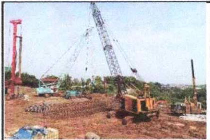
Erection tulangan bered pile dan persiapan pengecoran
