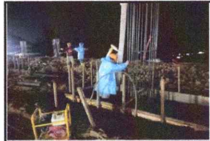
Pengecoran pile cap 5 titik di zona 1 Concrete Pump long boom
