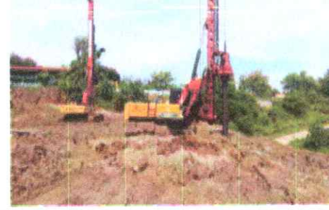
Pekerjaan Pengeboran Secant Pile
