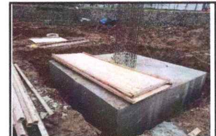
Kondisi Pile Cap setelah di alkukan pengecoran dan pelepasan bekisting
