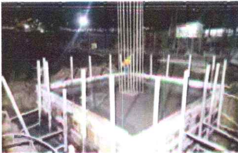
Pengecoran Pilecap
