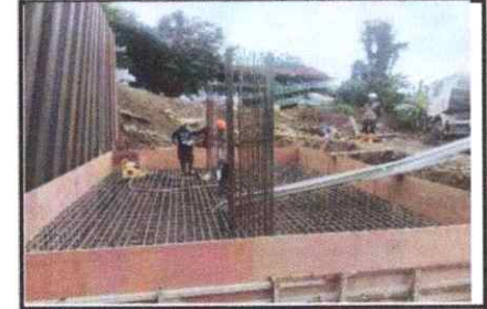
Pekerjaan bekisting pile cap zona 1
