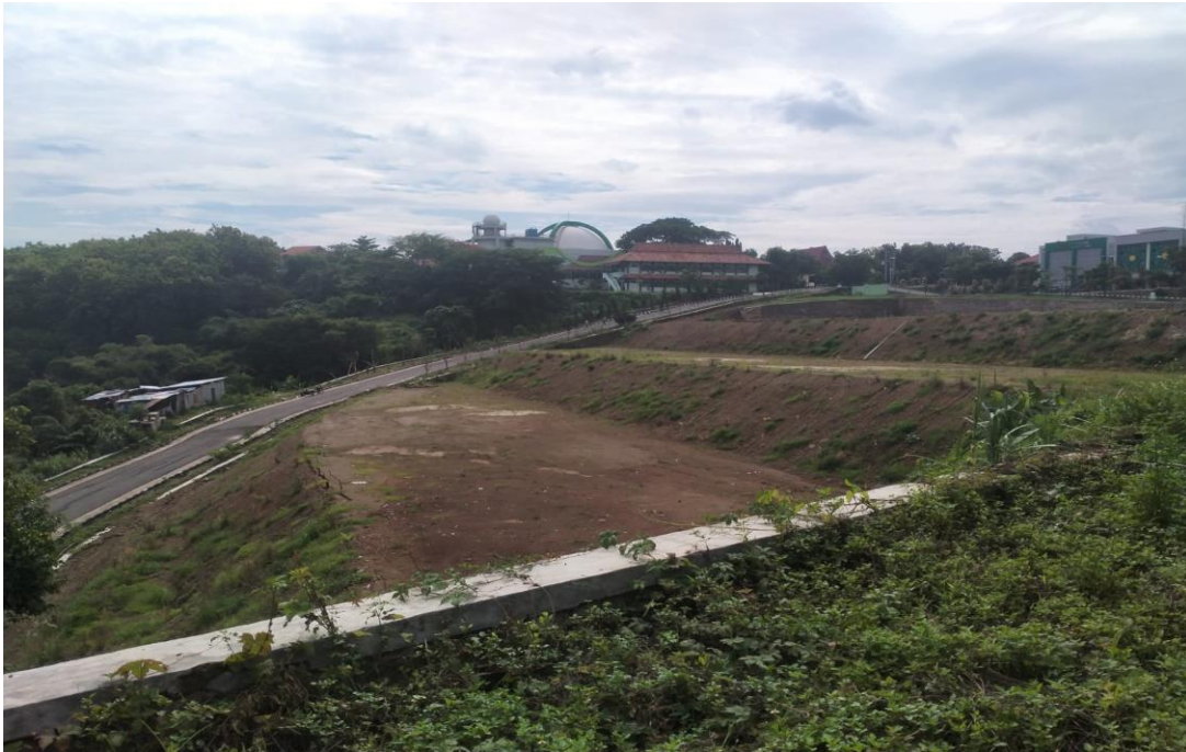
Dokumentasi Kondisi Awal Lahan Proyek Gedung Pendidikan Profesi Terpadu UIN Walisongo Semarang
